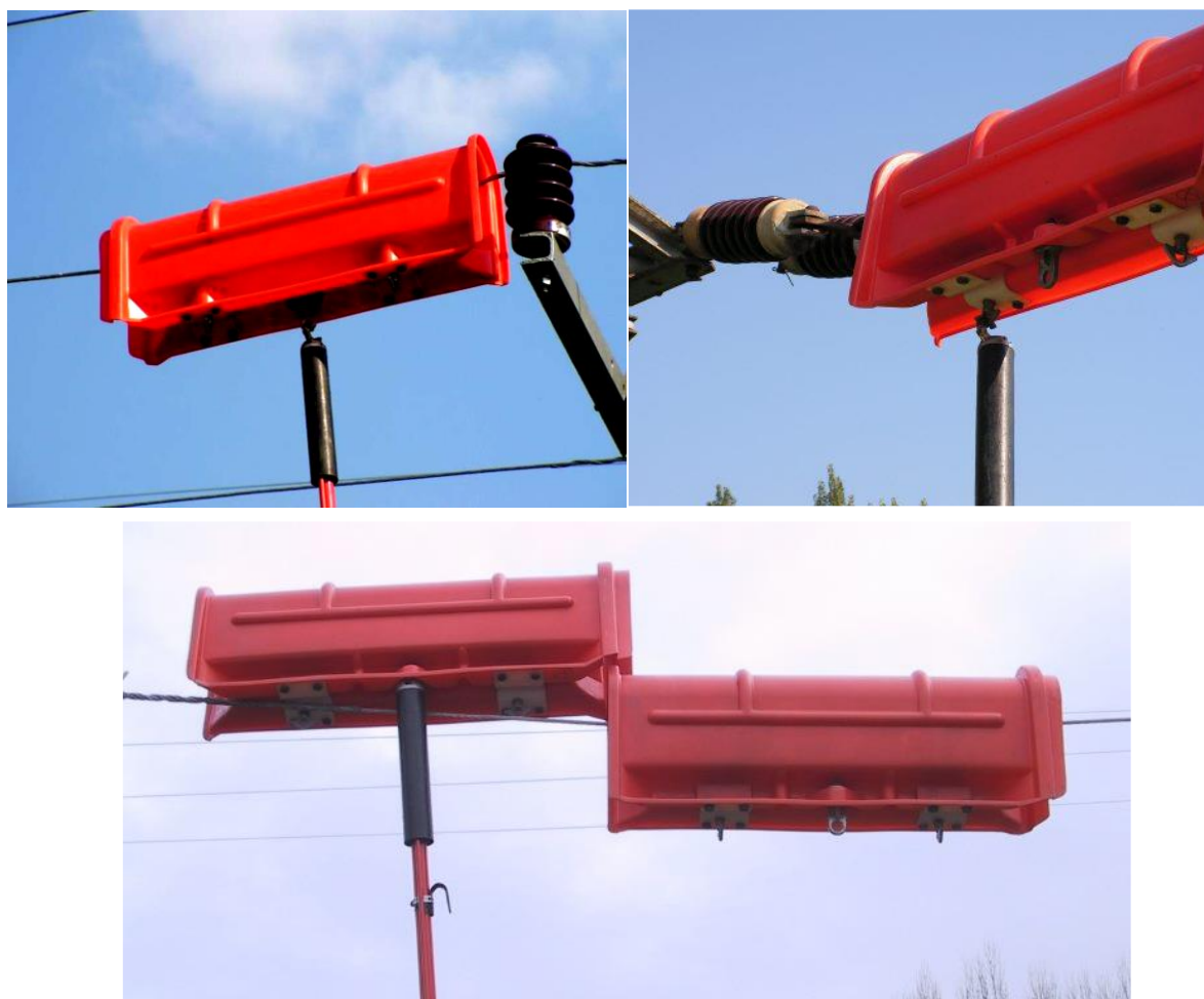
Exemple de utilizare a unor protectoare electroizolante pentru acoperirea unui conductor.
