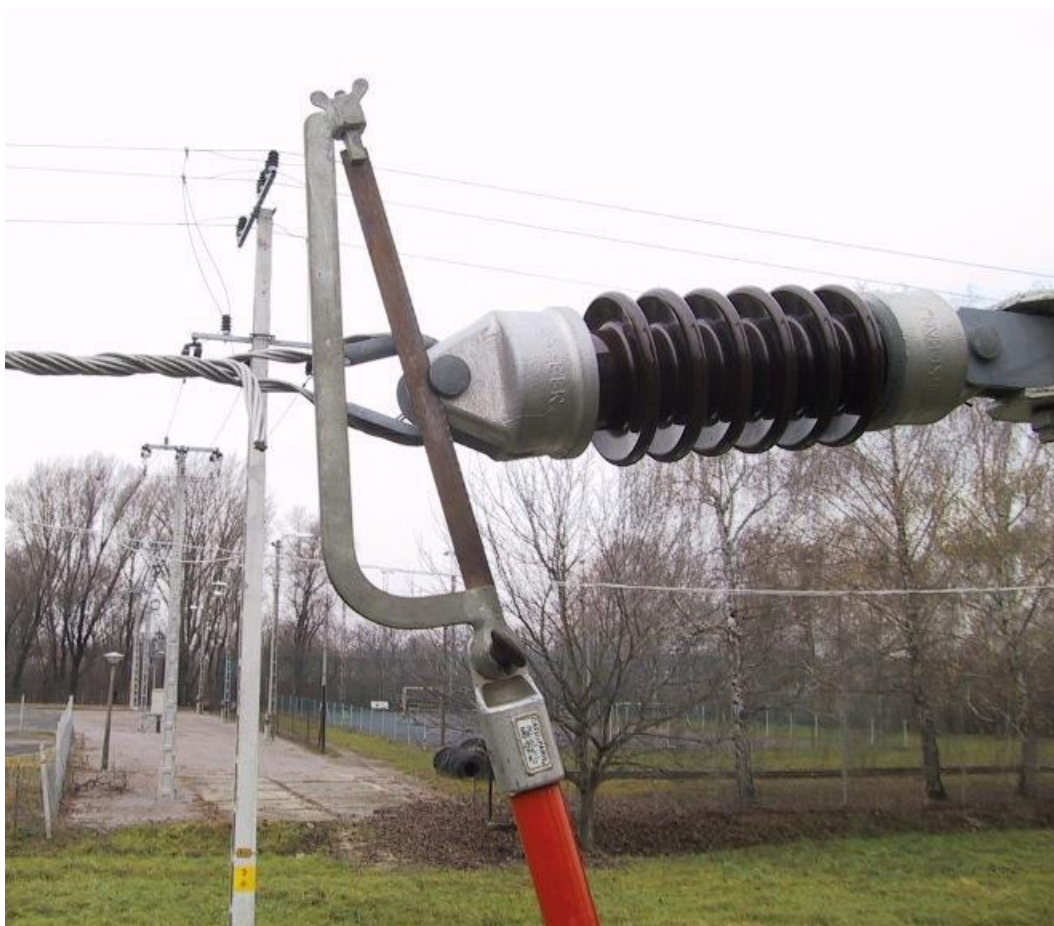
Exempu de utilizare fierăstrăului pentru taierea unui bolt al unui izolator de întindere
