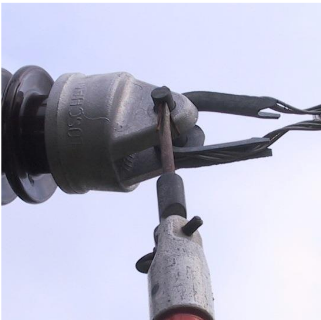
Exemplu de utilizare a șurubelniței pentru îndoirea unei agrafe a unui bolt al unui izolator de întindere
