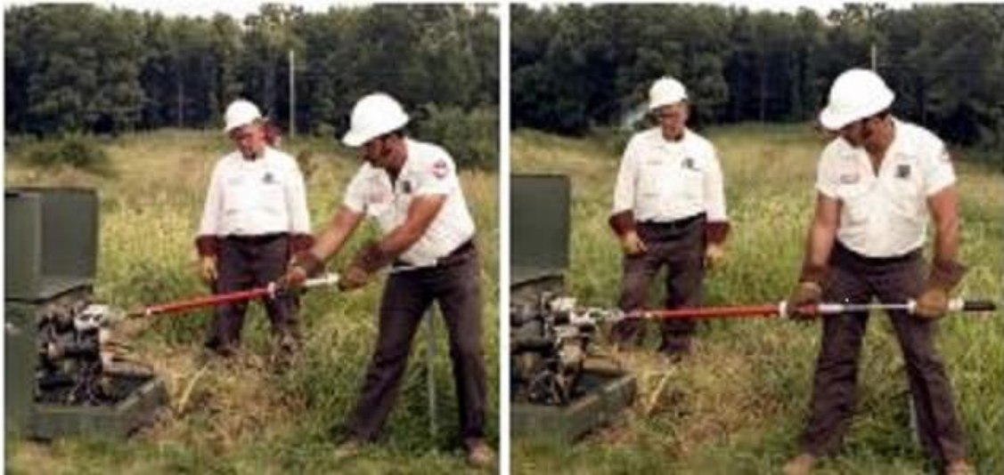
Exemple de utilizare a unui clește articulat pentru extragerea elementelor fuzibile
