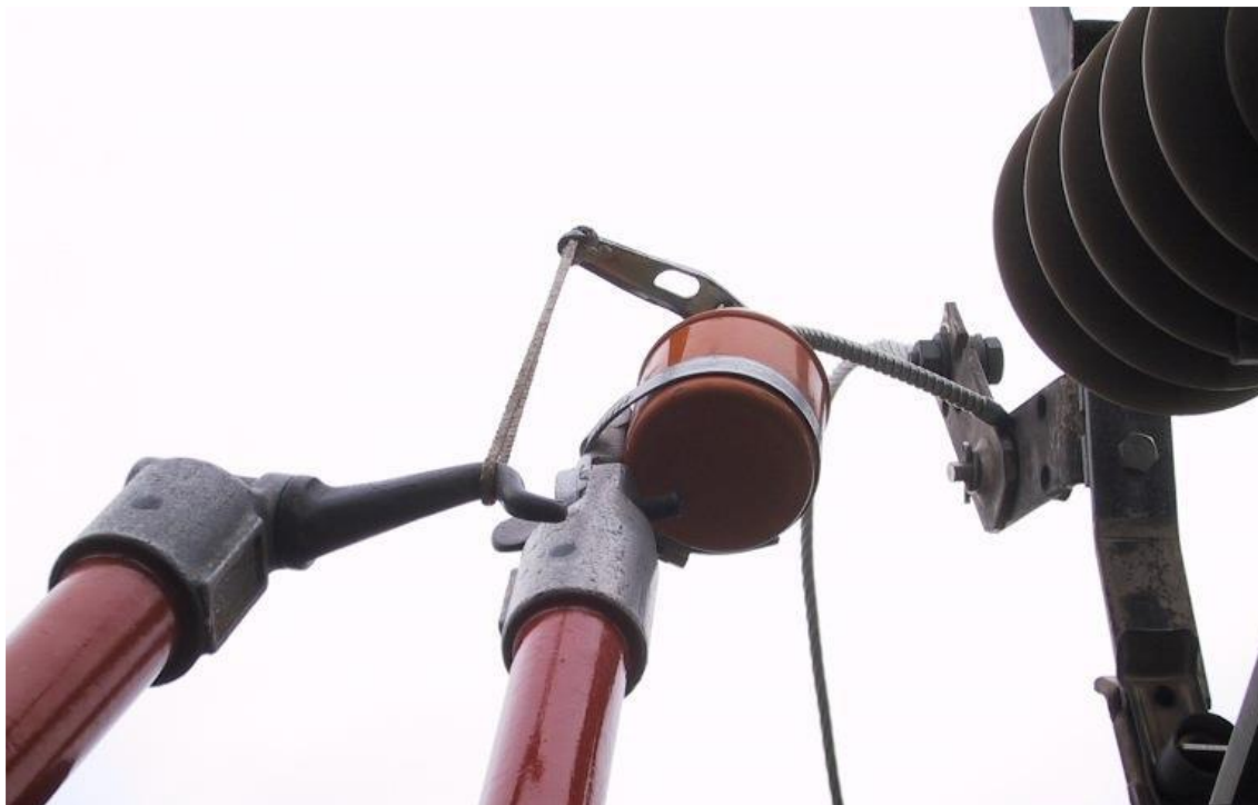
Exemplu de utilizare a pompei de ungere pentru lubrifierea articulației unui separator
