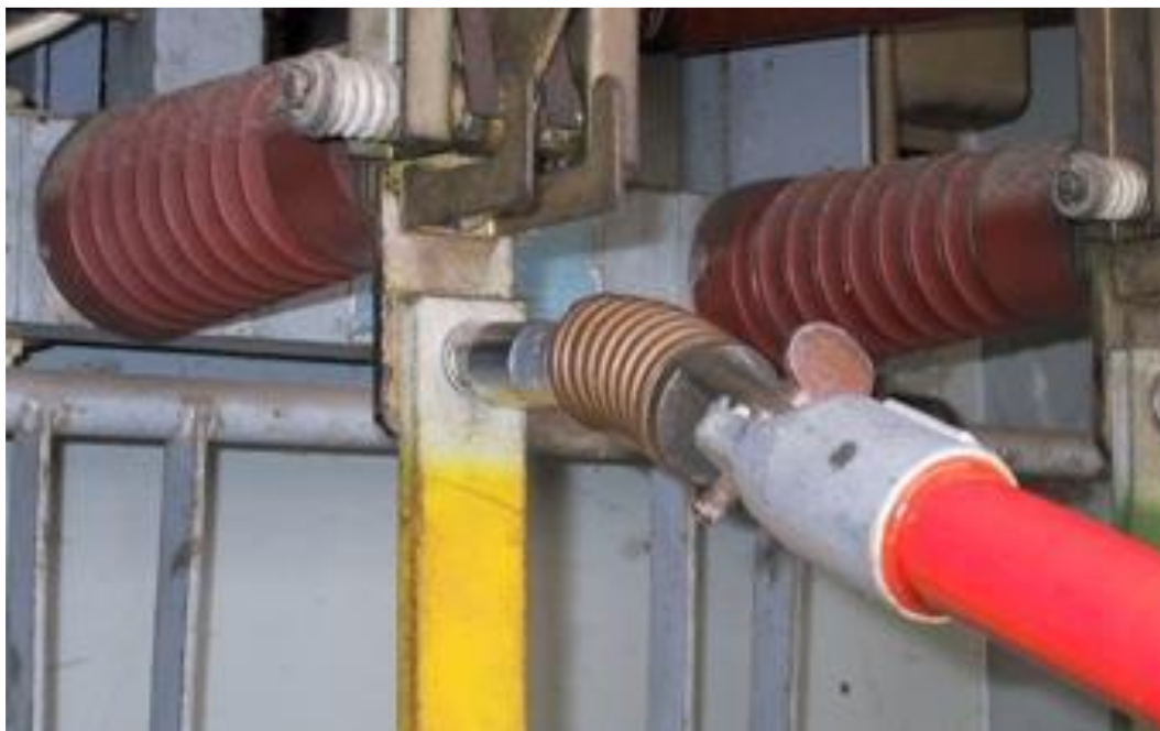
Exemplu de utilizare cheie tubulară cu cardan pentru desfacerea unei piulițe
