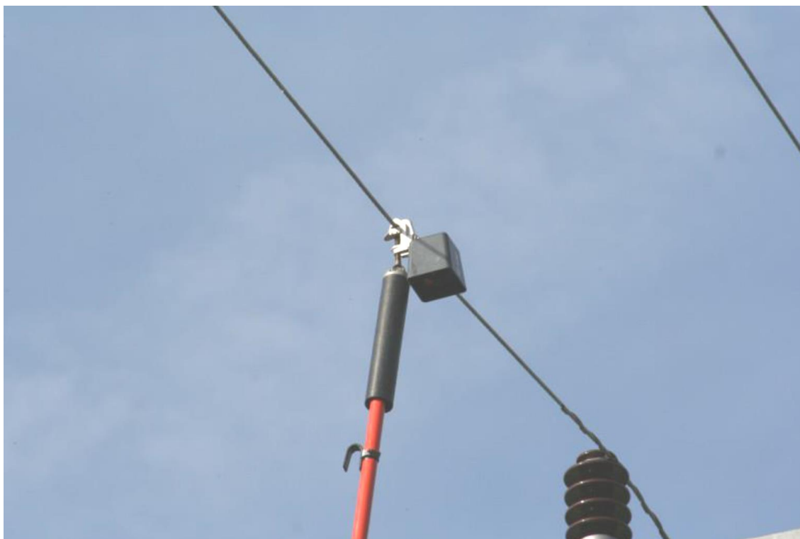
Exemplu de montare a unui indicator de lipsă a tensiunii cu ajutorul unei prăjini electroizolante
