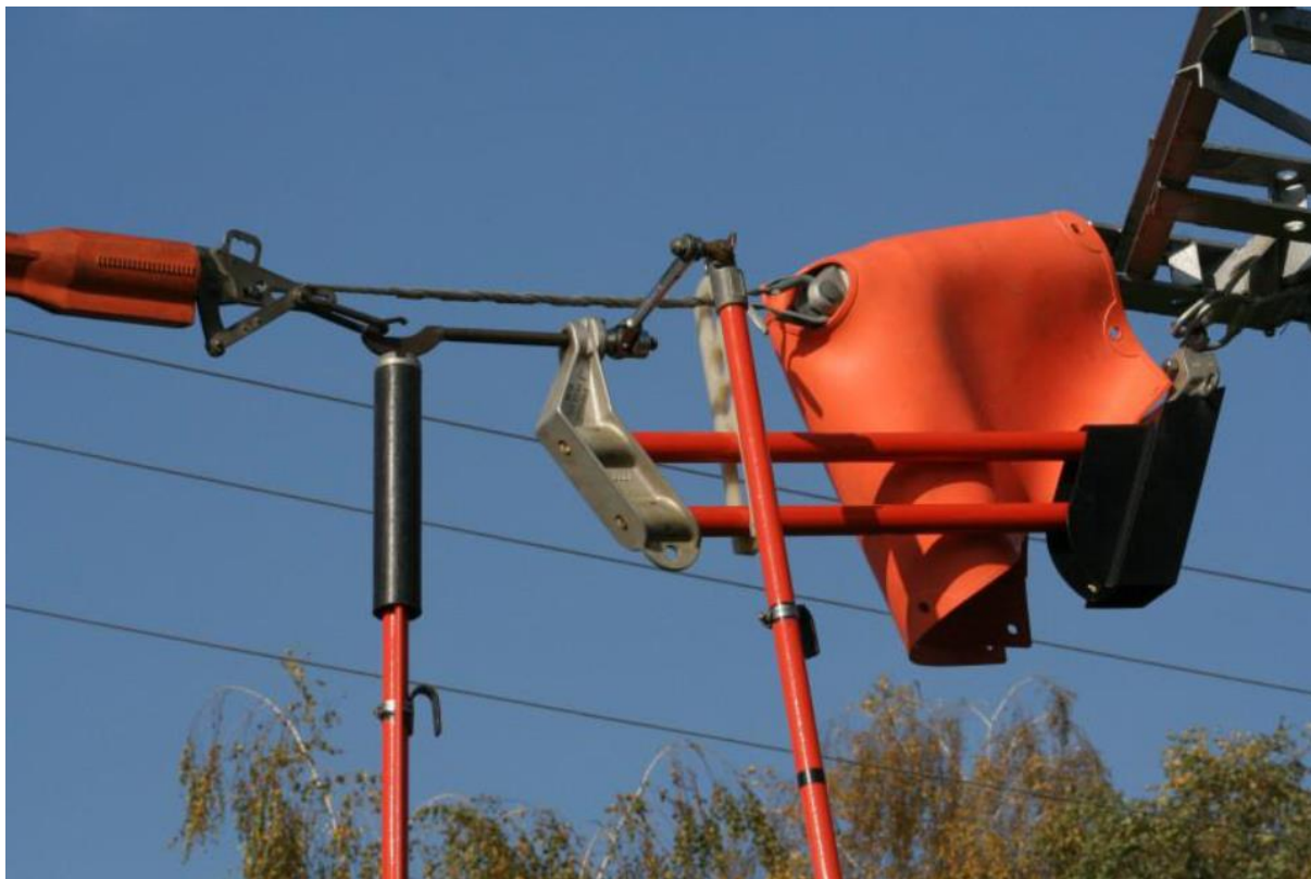
Exemplu de utilizare a unei chei cu clichet
