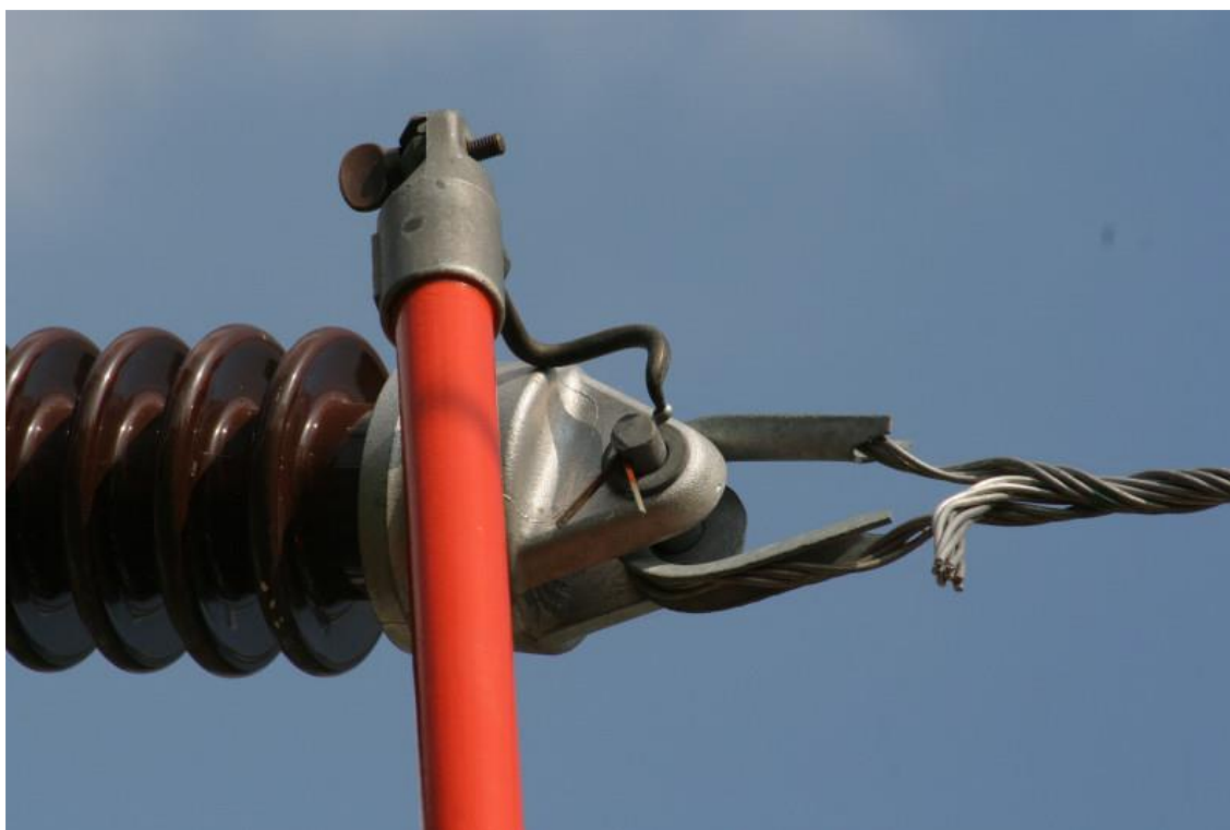
Exemplu de utilizare a unui dispozitiv ( de tip spiral ) pentru demontarea unei agrafe de blocare
