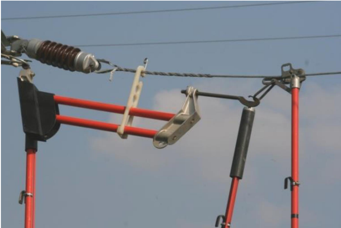
Exemplu de montare a unui tirant de detensionare cu ajutorul prăjinilor electroizolante
