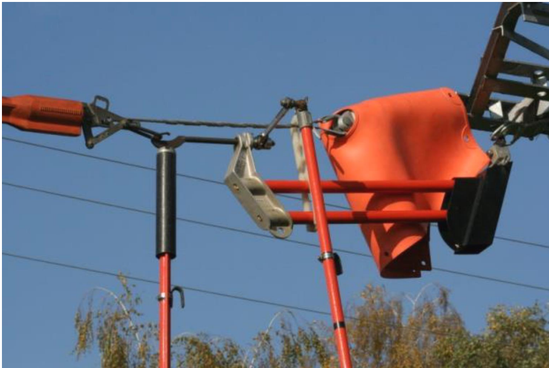
Exemplu de montare a unui tirant de detensionare cu ajutorul prăjinilor electroizolante
