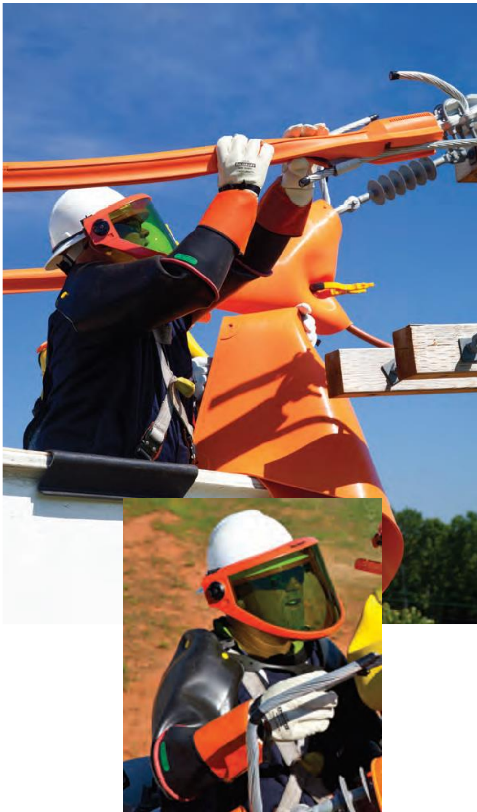
Exemple de utilizare a unor mâneci electroizolante pentru braț.
