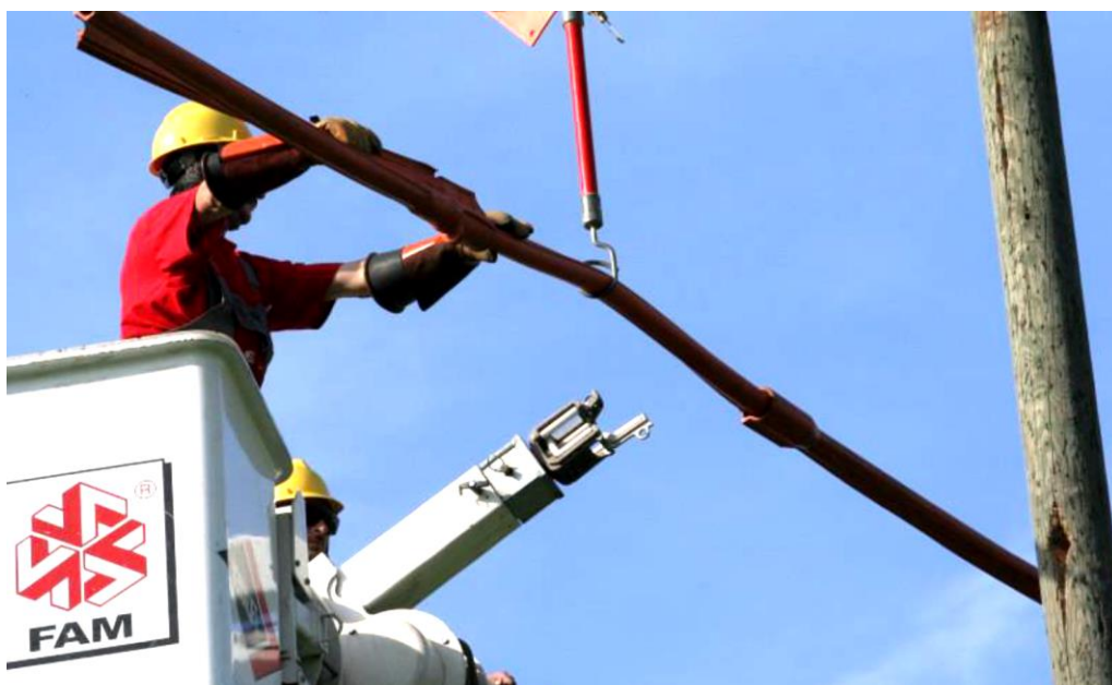
Exemple de utilizare a unor teci electroizolante pentru acoperirea unui conductor.
