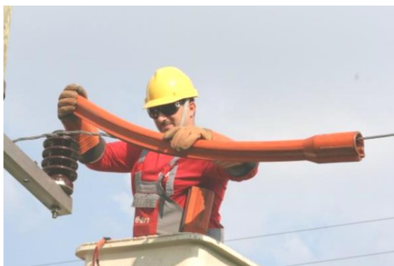
Exemple de utilizare a unor teci electroizolante pentru acoperirea unui conductor.
