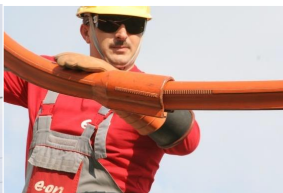
Exemple de utilizare a unor teci electroizolante pentru acoperirea unui conductor.
