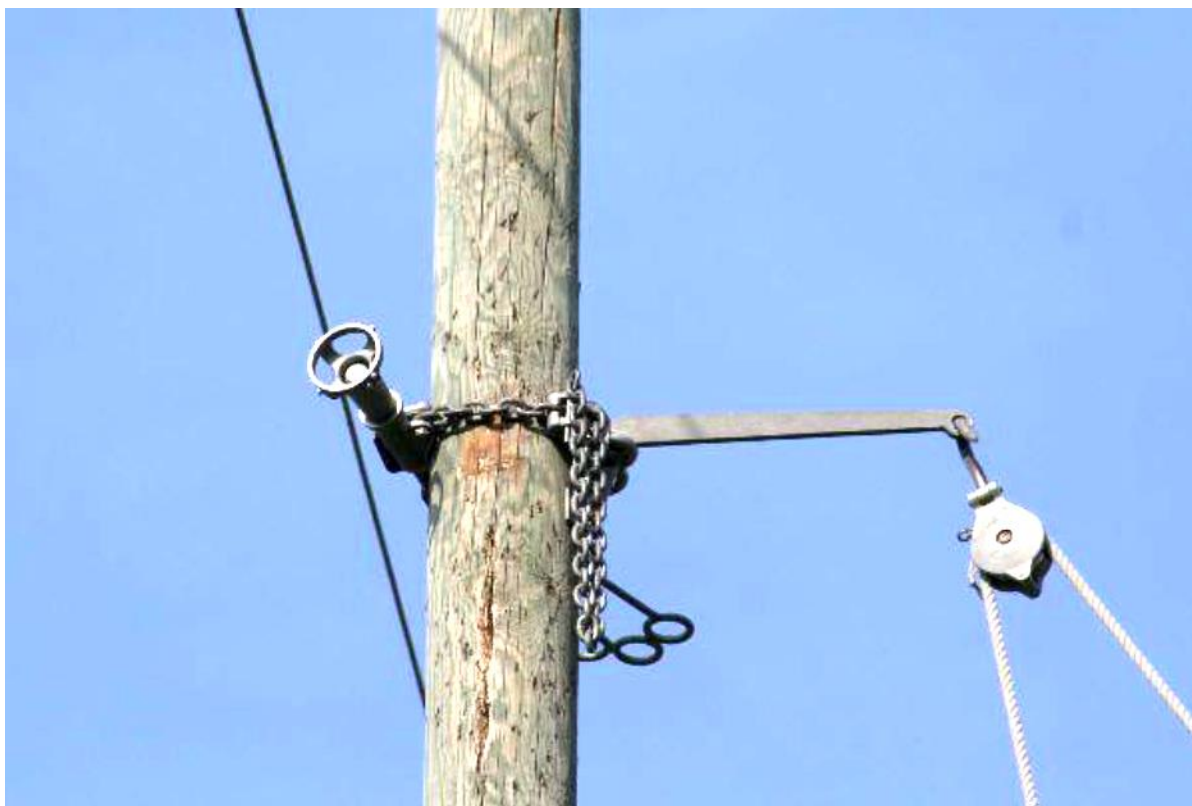
Exemplu de utilizare a unui scripete.
