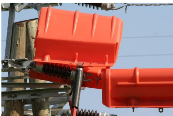
Exemple de utilizare a unui protector electroizolant pentru acoperirea unui lanț simplu de întindere.
