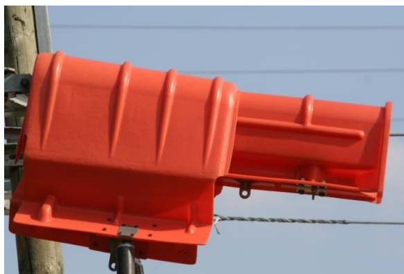
Exemple de utilizare a unui protector electroizolant pentru acoperirea unui lanț simplu de întindere.
