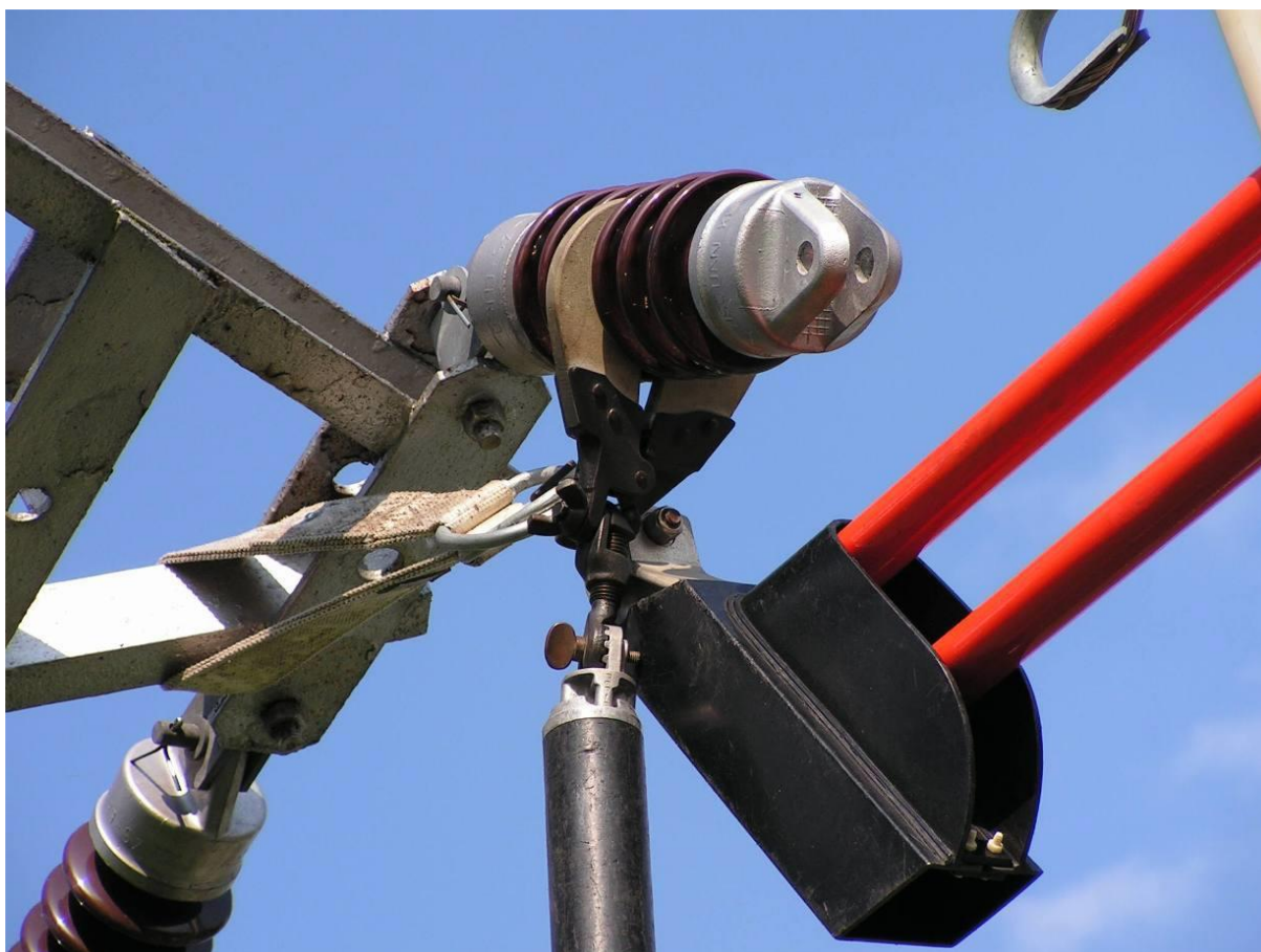
Exempu de utilizare cleștelui pentru manevrarea unui izolator de întindere
