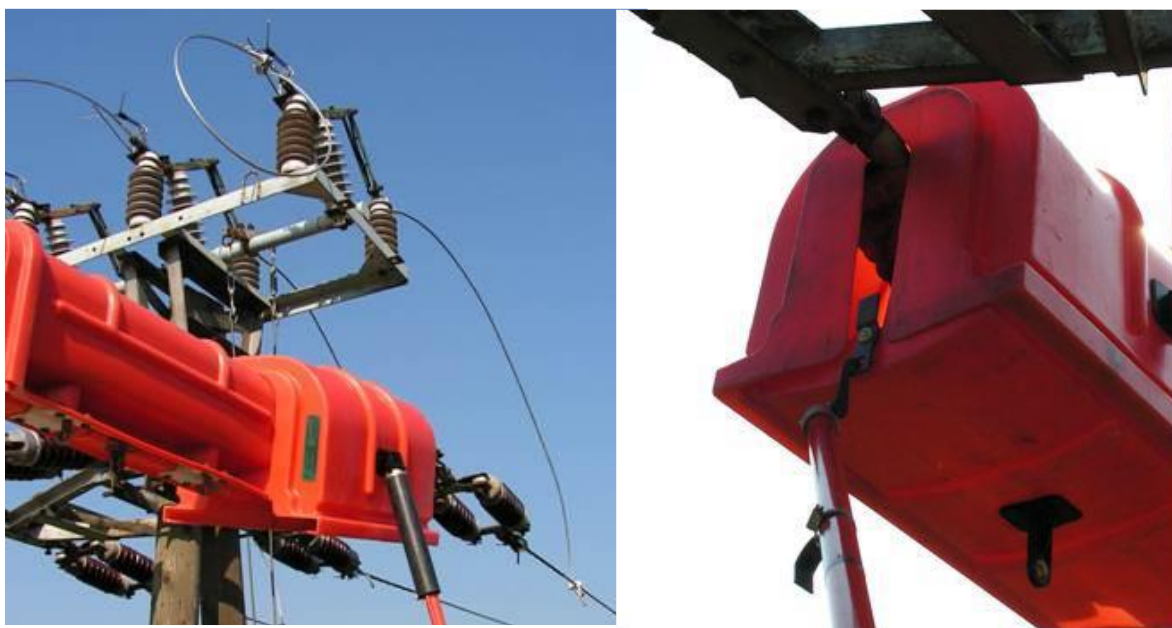
Exemple de utilizare a unui protector electroizolant pentru acoperirea unui lanț dublu de întindere.
