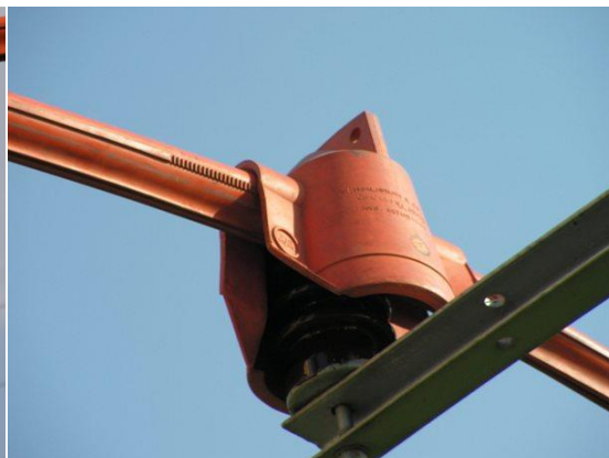
Exemple de utilizare a unui protector flexibil electroizolant pentru izolator suport.
