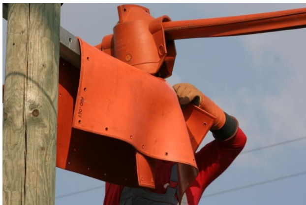
Exemple de utilizare a unui protector flexibil electroizolant pentru izolator suport.
