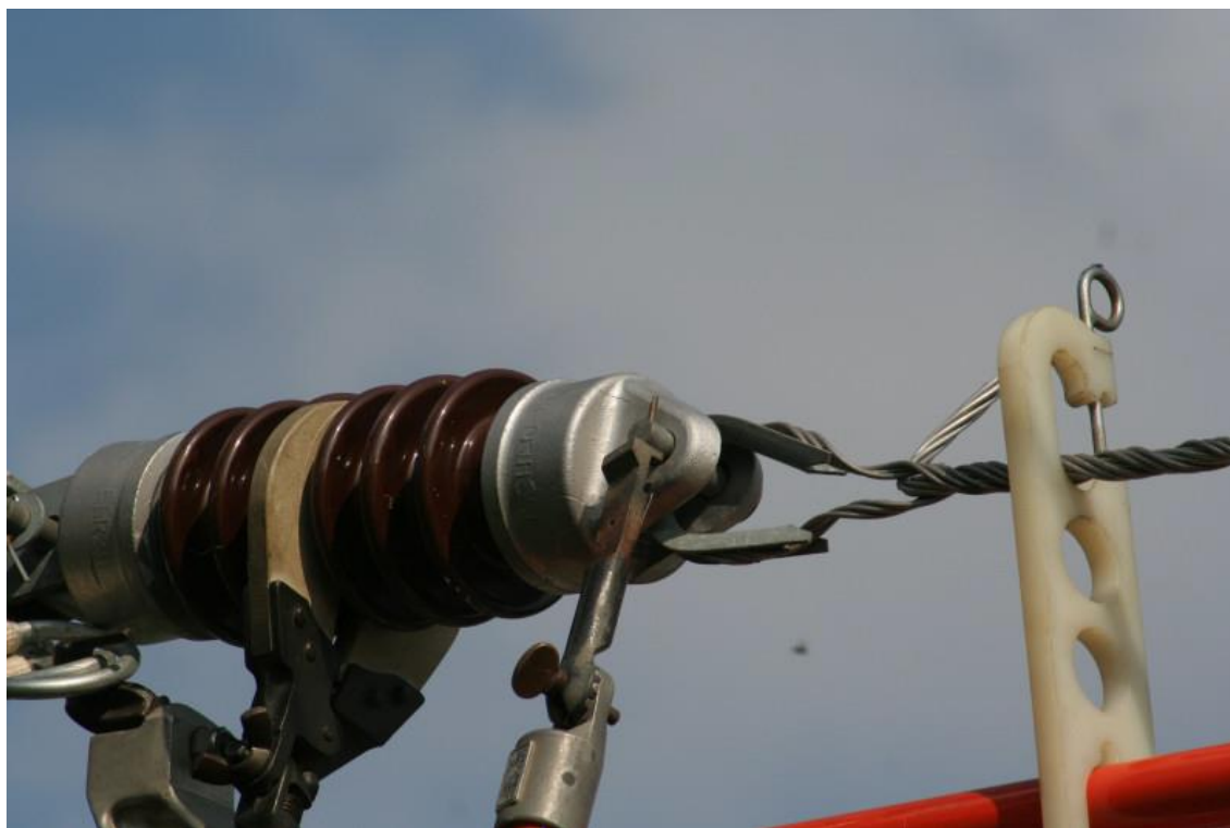
Exemplu de utilizare a a unui dispozitiv pentru montarea unei agrafe de blocare
