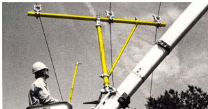
Fig. 3 Exemplu dispozitiv pentru suspendarea temporara a fazelor
