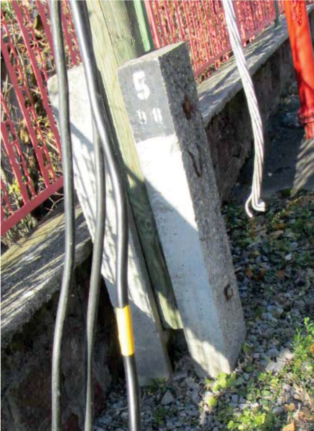
Foto 3. Stâlp de lemn cu 2 adaosuri de beton ( orientativ)
