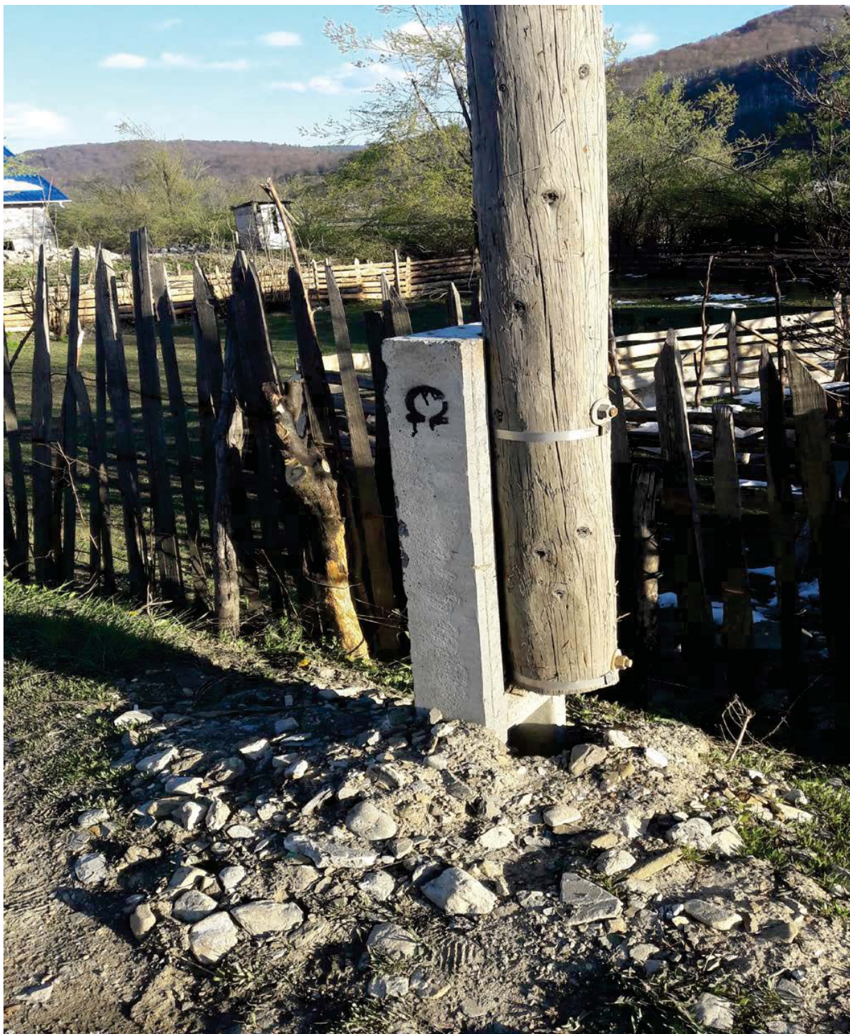
Foto 2. Stâlp de lemn cu un adaos de beton ( orientativ)
